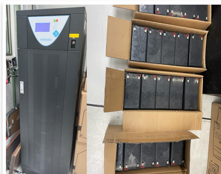
Ilustración 45. Cambio de baterías a unidad de suministro ininterrumpido de energía (UPS).
